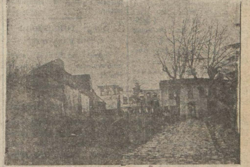
Yanması, bazı mühim dedikodulara sebep olan 45 odalı konağın enkazı
